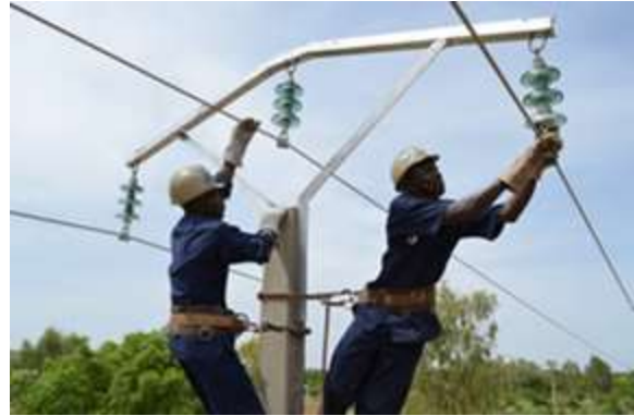
Figure 7 : Montage de l'isolateur
