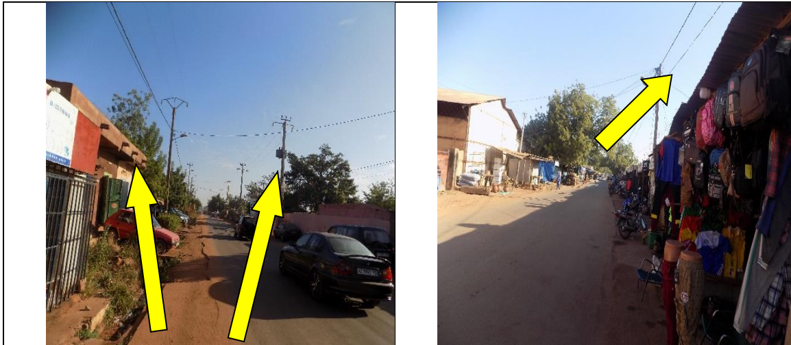
MT existantes et d'encombrement du tracé de la variante 1 (RN27 au centre-ville de Koulikoro)
