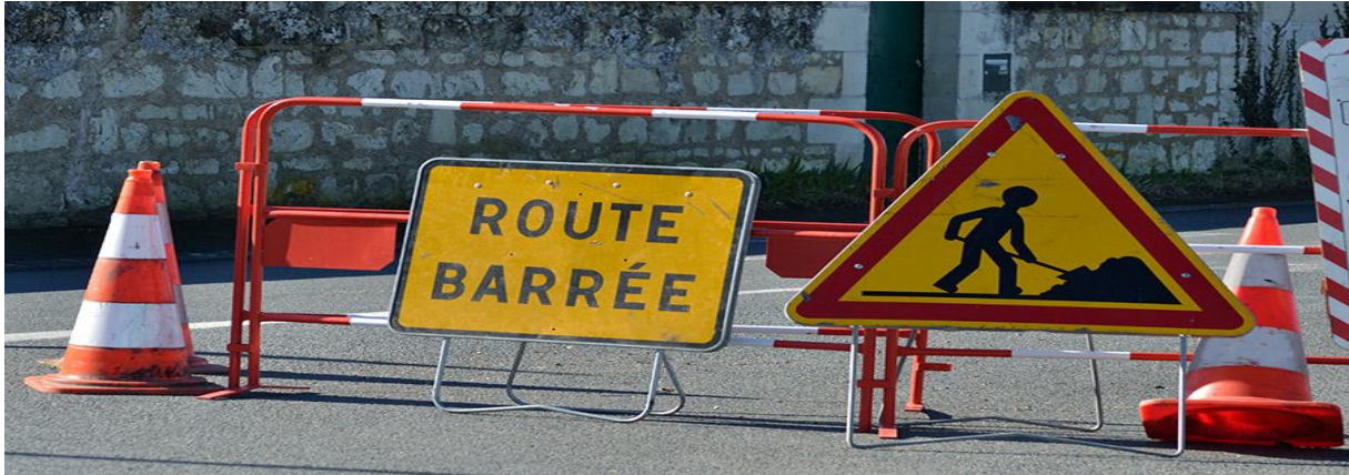
Figure 12: Signalisation d'une route barrée
