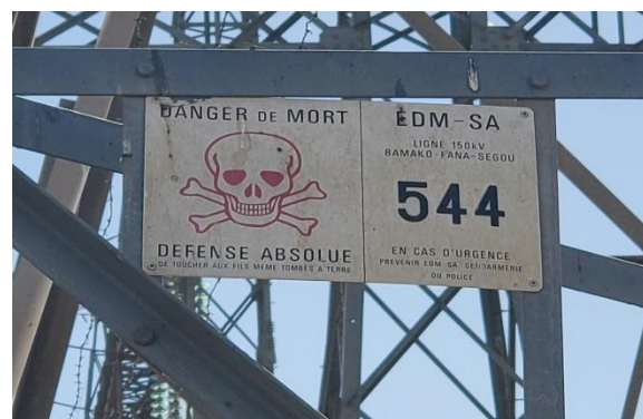
Figure 20. Dernier pylône ligne HT 150 kV Bamako – Fana – Ségou (Longueur totale : 220,784 km)
